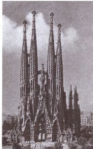
А. Гауди. Церковь Саграда Фамилия в Барселоне. 1884—1926 (не завершена).
