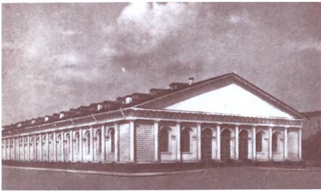
Манеж в Москве. 1817—25. Инженер Л. Л. Карбонье, по проекту А. Бетанкура, архитектор О. И. Бове.
